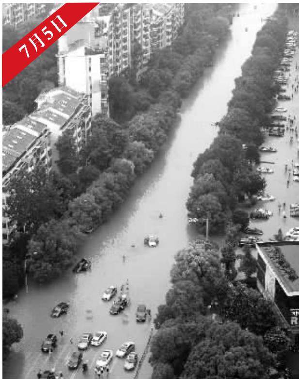
7月5日,银城东苑小区门口的道路积水严重
