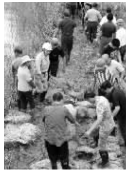
镇江薛港村破圩涵抢修现场
