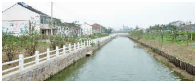
河道整治后面貌一新
