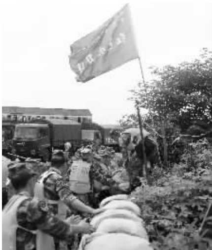
秦淮河七桥瓮河段,为防止河水漫堤,官兵们在原堤坝旁边重新垒出一道堤坝 余海波摄
