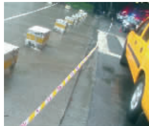
电线断裂掉在地上
