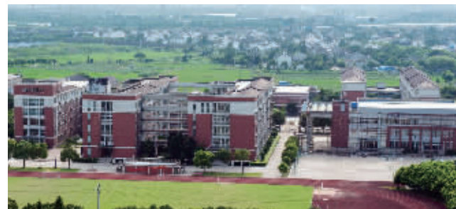
校园俯瞰 学校供图
