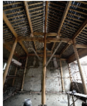
凤凰台遗址复建项目开工 现代快报记者 赵杰 摄
