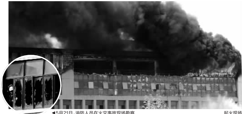
◀5月21日,消防人员在火灾事故现场勘察
