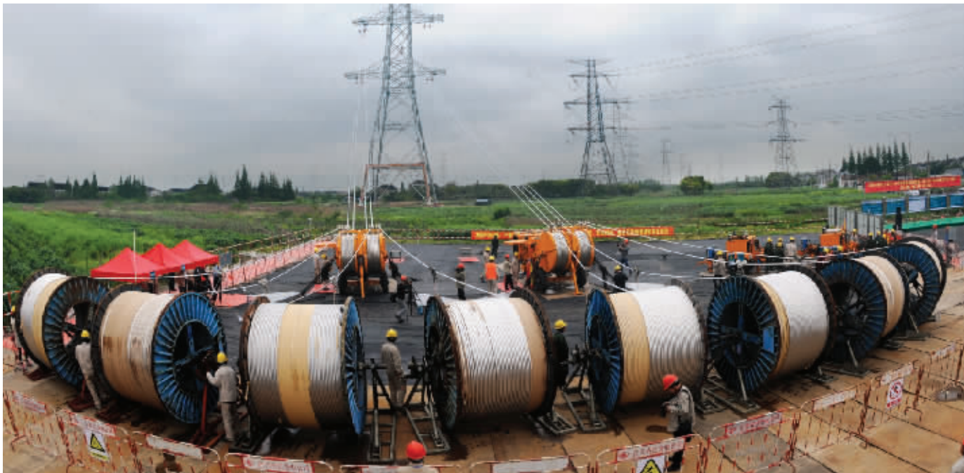
施工现场 通讯员供图
