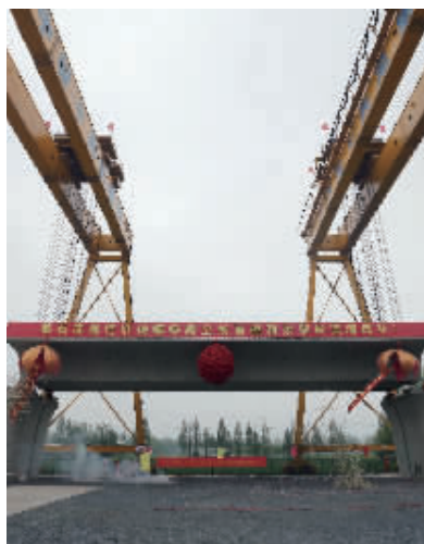
连淮扬镇铁路开工现场 通讯员供图
