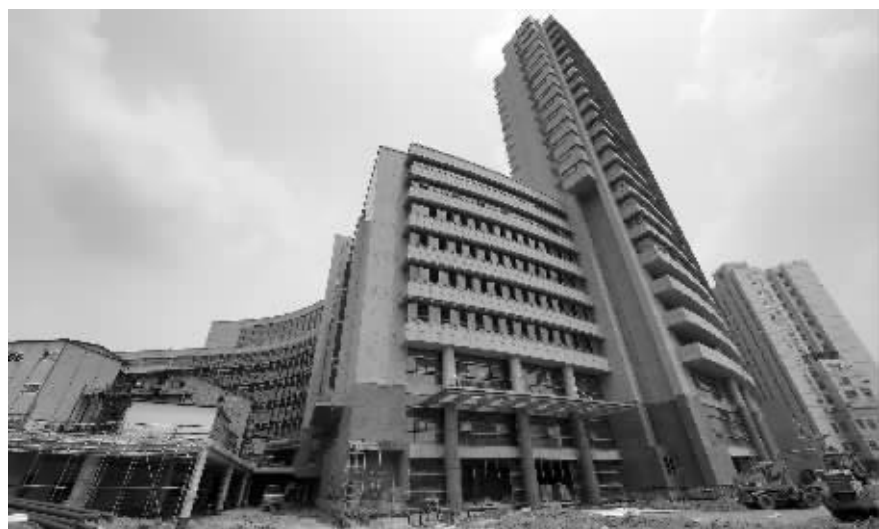
正在进行内部装修的江苏省人民医院新门诊大楼 现代快报记者 施向辉 摄
