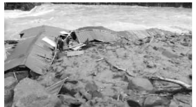
因强降雨造成的山体滑坡事故现场(手机图片)
