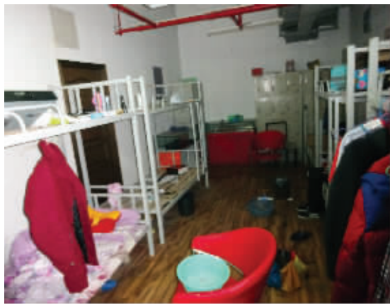
地下自行车库隔出来的宿舍
