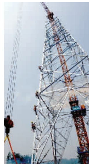
塔位塔身段开吊 吴江 摄
