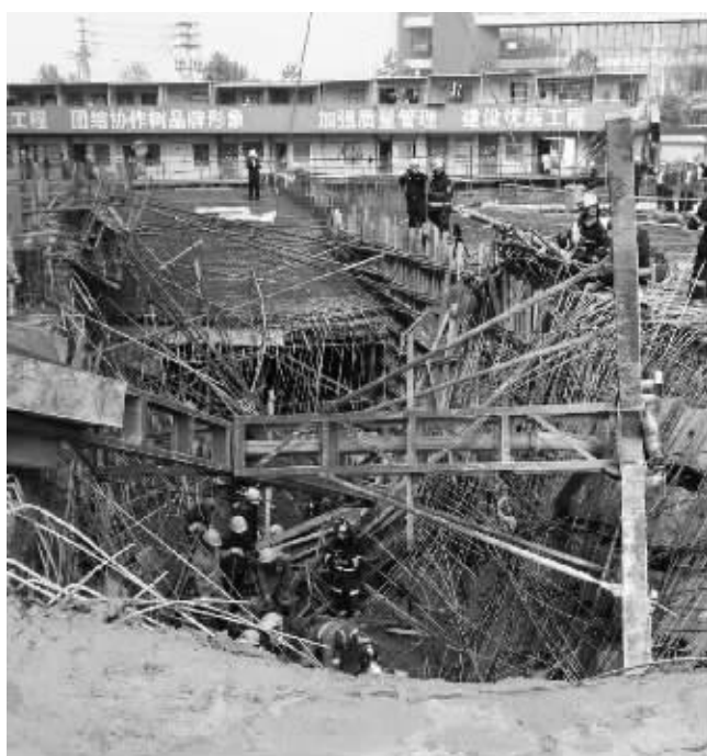
事故发生后,消防、民警和工人一起参与救援 现代快报记者 马晶晶 摄
