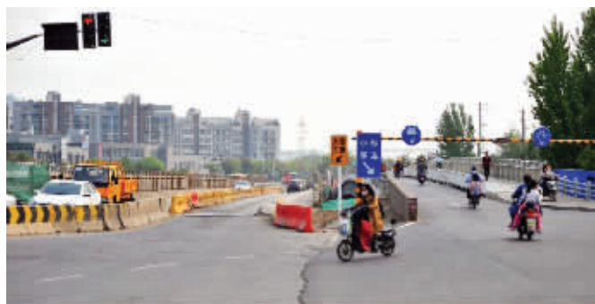
正在改扩建中的铁心桥 丁劫 摄
