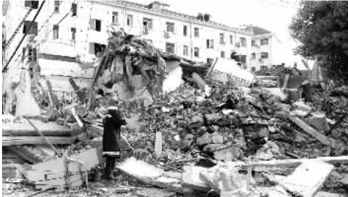
房屋坍塌现场
