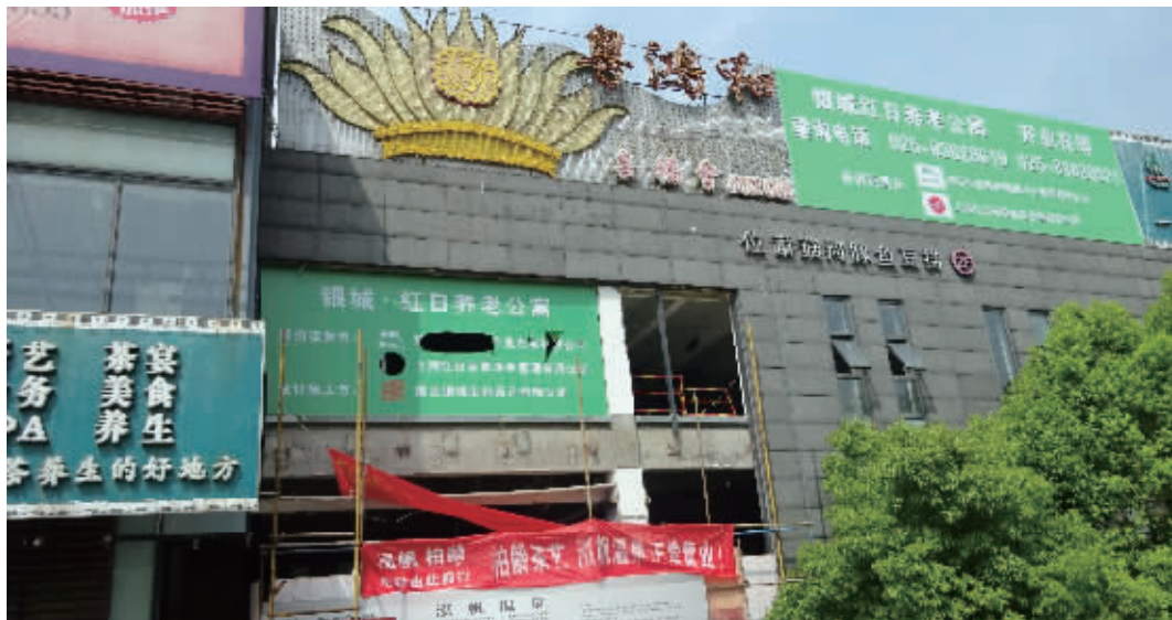
银城虹口养老公寓正在改建中
