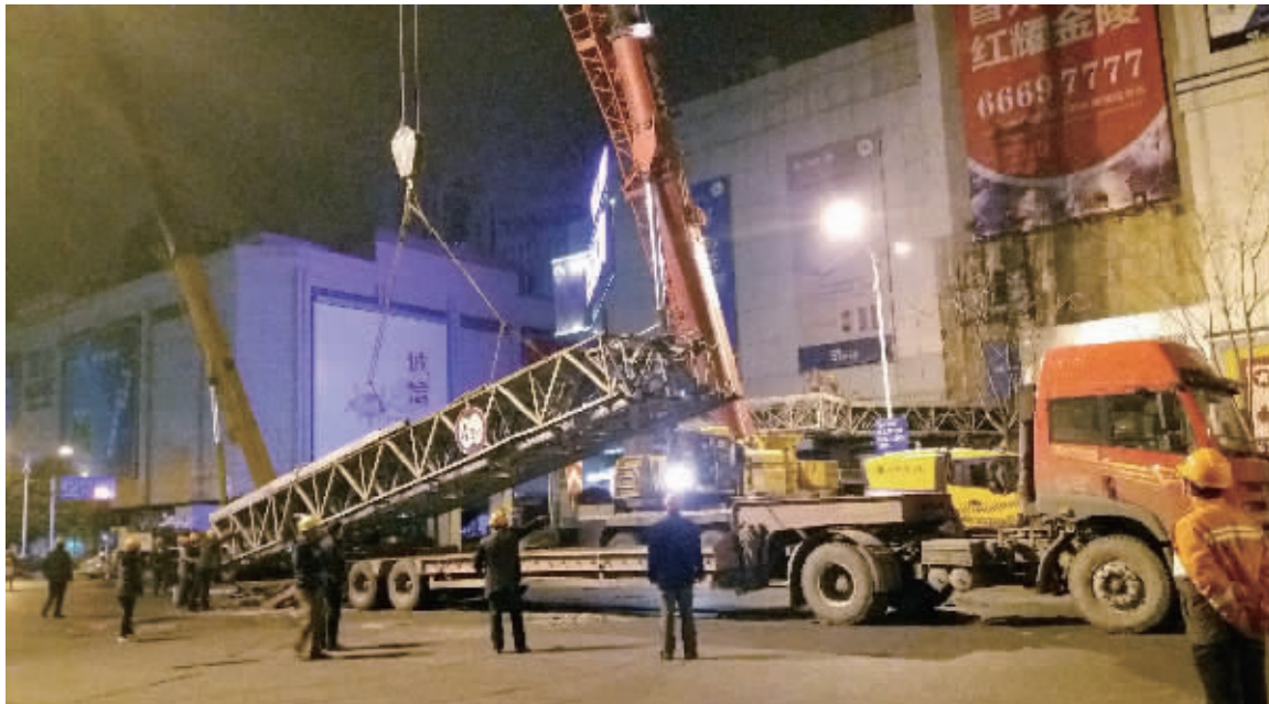
昨天凌晨,起重机将天桥主梁的一部分吊上拖车 现代快报记者 李娜 摄
