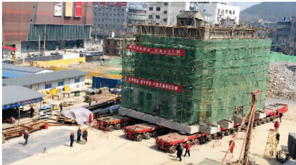
3台大型平板车搬运老建筑 现代快报记者 李伟豪 摄
