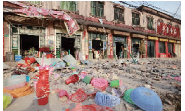
山西省运城市盐湖区龙居镇的房屋因地震受损 新华社发(鲍东升 摄)
