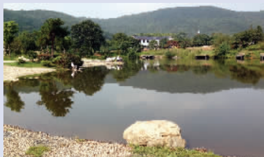
龙寺生态园水土保持项目一大灶池塘坝工程
