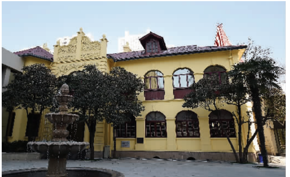
公余联欢社旧址出新基本完工
