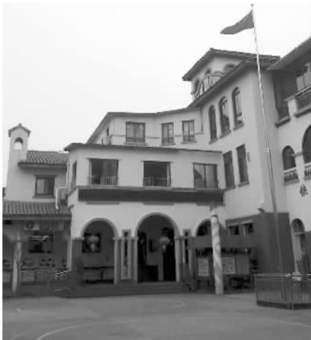
幼儿园的部分违建正在拆除
