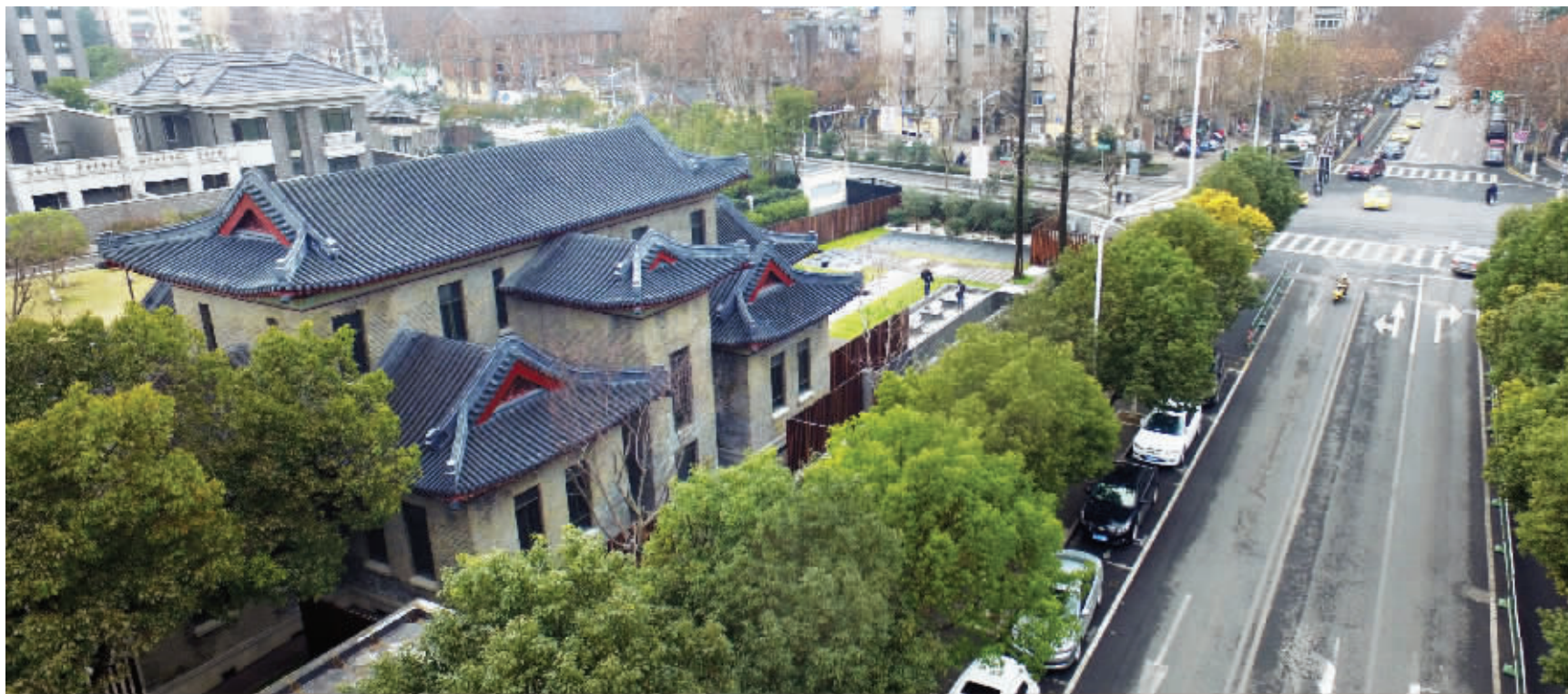
位于鼓楼区老菜市口8号的民国荷兰大使馆旧址修缮完毕 现代快报记者 马晶晶 摄
