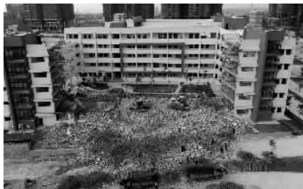
教学楼拆除现场
