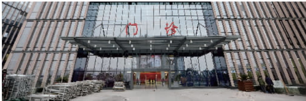
南京儿童医院河西院区门诊大楼
