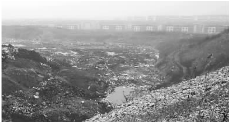
南京地铁麒麟专用弃土场,不远处有居民小区
