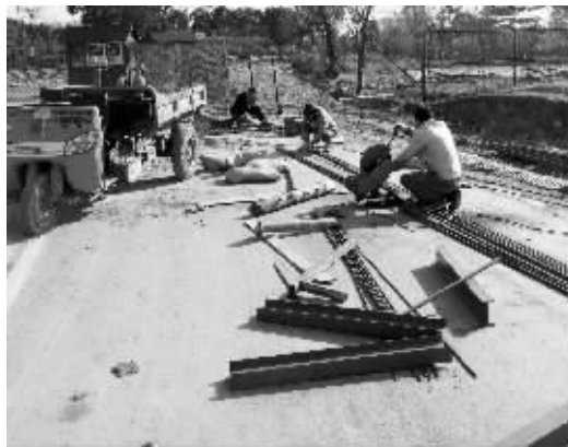
动物园自驾区的小山坡旁,几名工人正在施工
