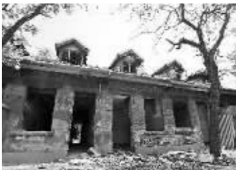
被拆毁的南化三村工业遗存
