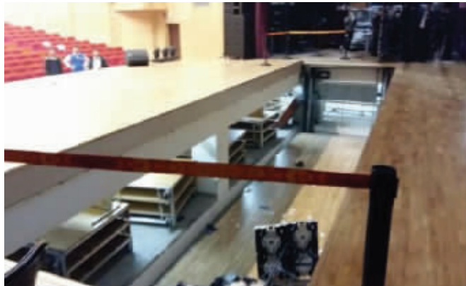
坍塌事故现场
