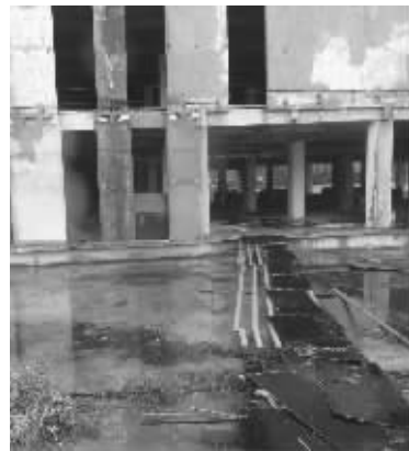
工地内并无人员施工
