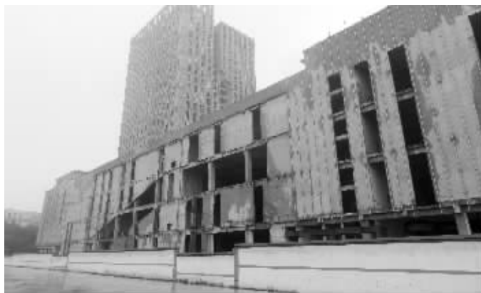
这幢建筑施工停工已经有两年多
