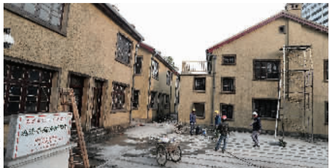
外墙修缮结束
