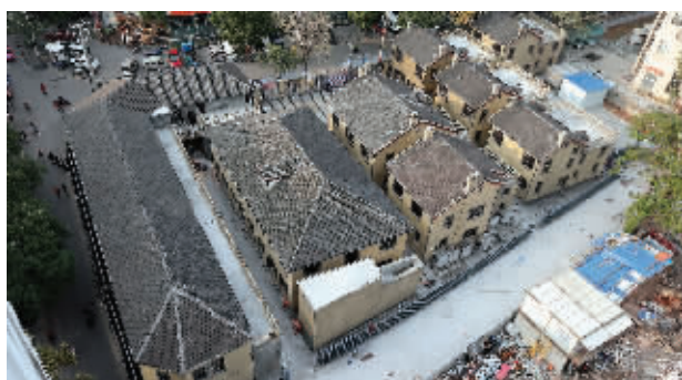
目前慰安所旧址正在内部修缮 现代快报记者 顾炜 摄
