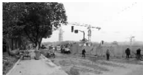
雨花路正在进行拓宽 现代快报记者 赵杰 摄
