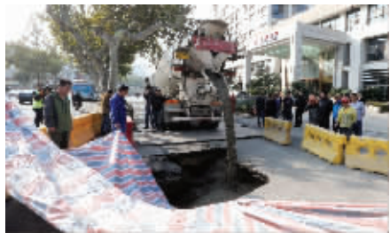
施工人员填埋坑洞 现代快报记者 马晶晶 摄
