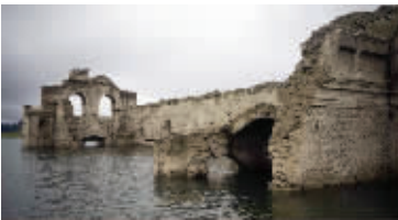
教堂墙壁斑驳、建筑残破
