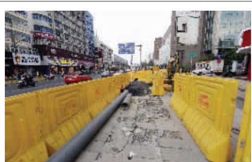
湖南路人行道围挡起来进行地下管线迁移
