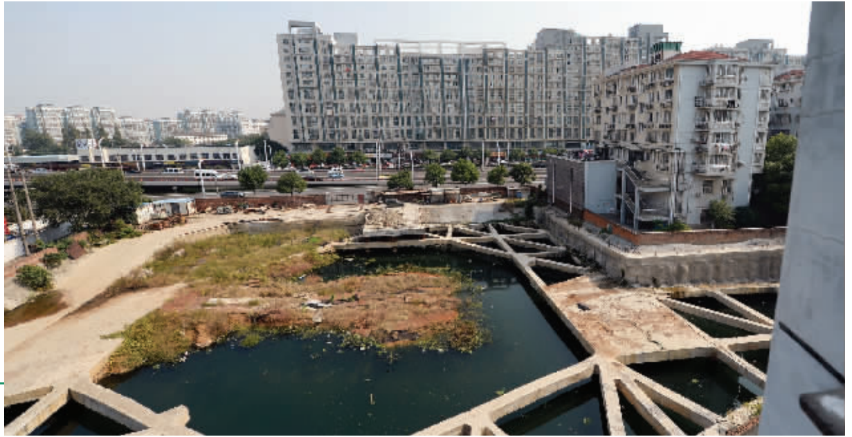
工地深基坑紧挨着南方花园居民楼 现代快报记者 施向辉 摄
