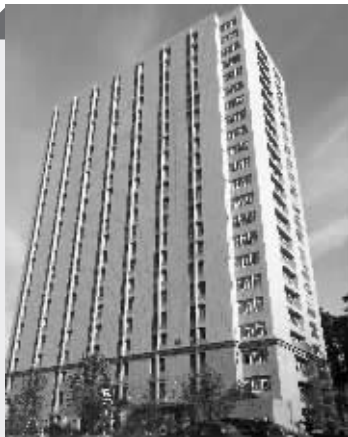
南京脑科医院22层新大楼
