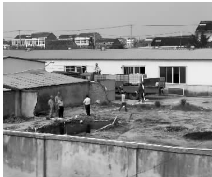
工作人员正在清理养猪场的污水坑
