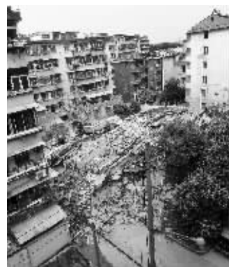
6层楼房全部坍塌
