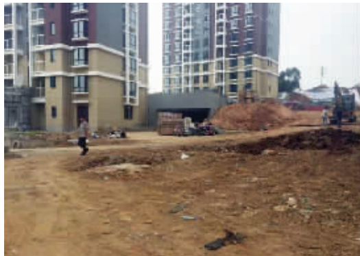
项目工地上只有少量工人在施工
