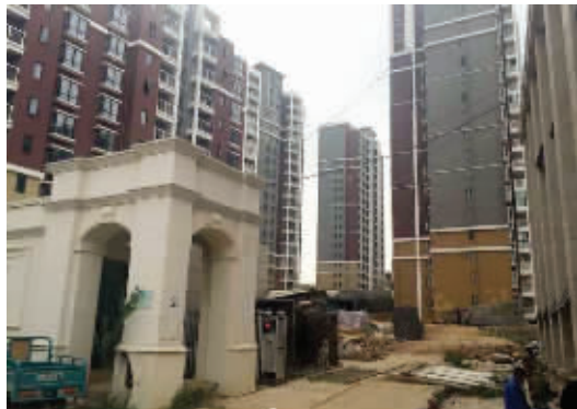
小区主体工程已经建好
