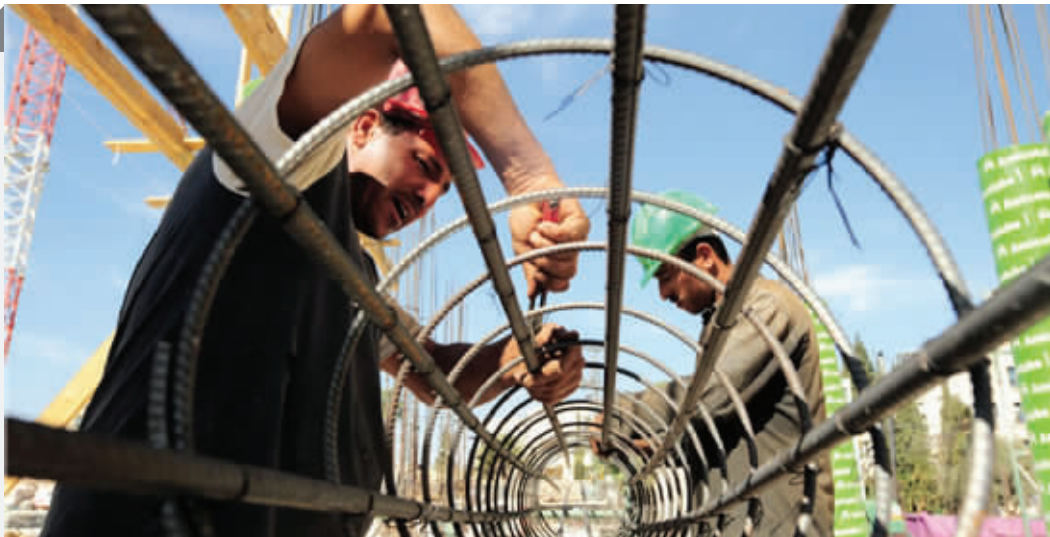
建筑工人在耶路撒冷市中心一处住宅楼建筑工地施工
