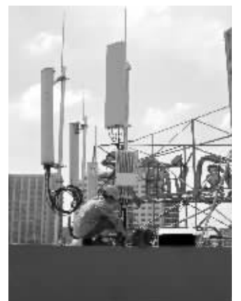
移动网络施工人员在安装楼顶站设备 江苏移动供图
