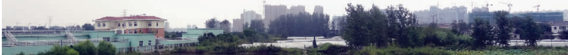
污水处理厂(图左)靠着袁桥组(树林后面)
