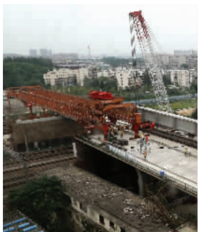
跨铁路的主桥部分正在施工 现代快报记者 马晶晶 摄
