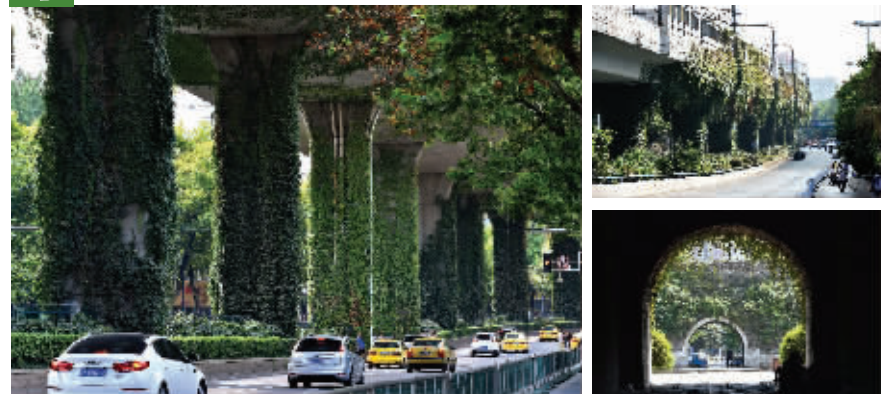
高架桥上的爬山虎修剪过了,汉中门城墙上的爬山虎又长出来了 现代快报记者 赵杰 摄
