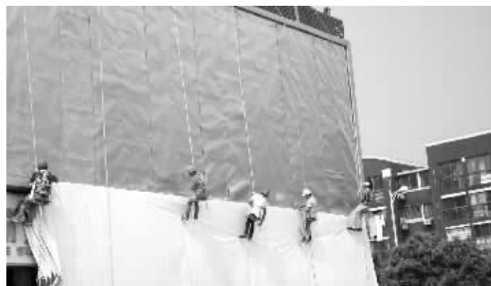
违规广告牌正在拆除 通讯员供图
