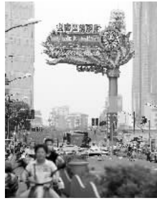
火炬立柱也将暂时拆除
